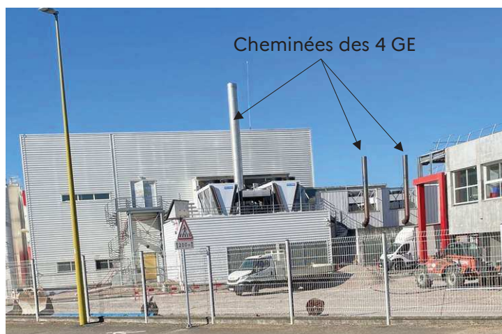
Groupes électrogènes considérés comme raccordables
