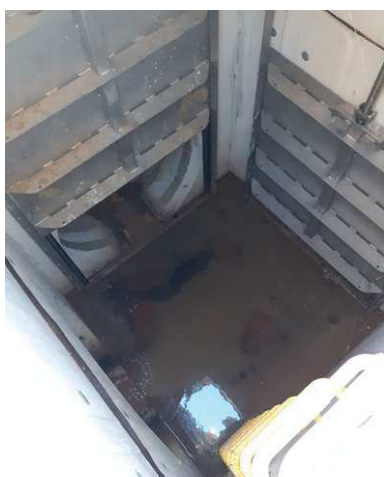
Bassin de confinement – Vannes amont
